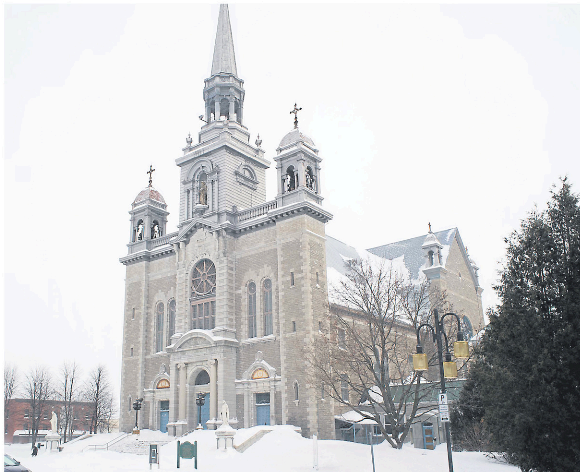
L'église Saint-Paul du secteur Grand-Mère doit subir d'importants travaux d'entretien. — PHOTO: SYLVAIN MAYER
