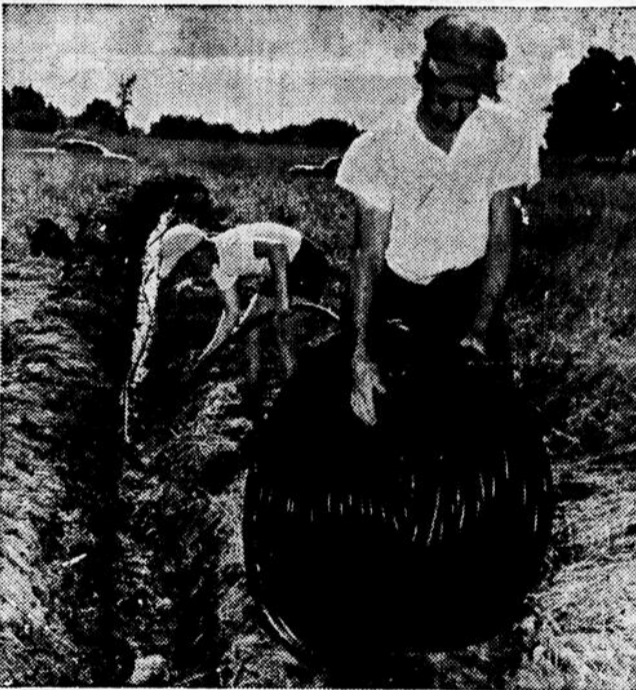
UN TUYAU EXTRAORDINAIRE en plastique flexible a révolutionné la pose de conduites d'eau. Fait de polythène, un produit de la C-I-L, ce tuyau se coupe au couteau ou à la scie, se joint par de simples raccords vissés, et peut se poser dans des tranchées rudimentaires (il suffit de contourner les obstacles!).
