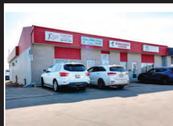
905-915, rue de Parfondeval
