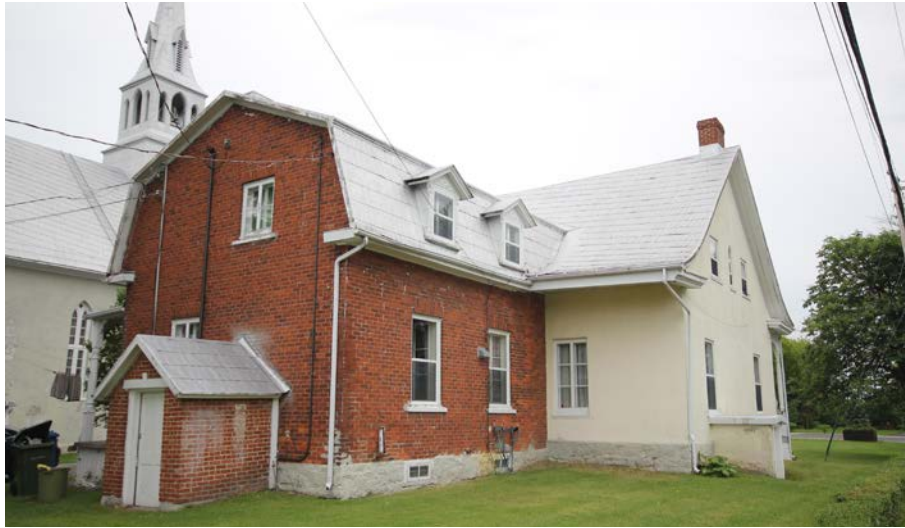
18. Le presbytère et son annexe, exhaussée par un toit comble en 1905 (photo Luc Noppen)
