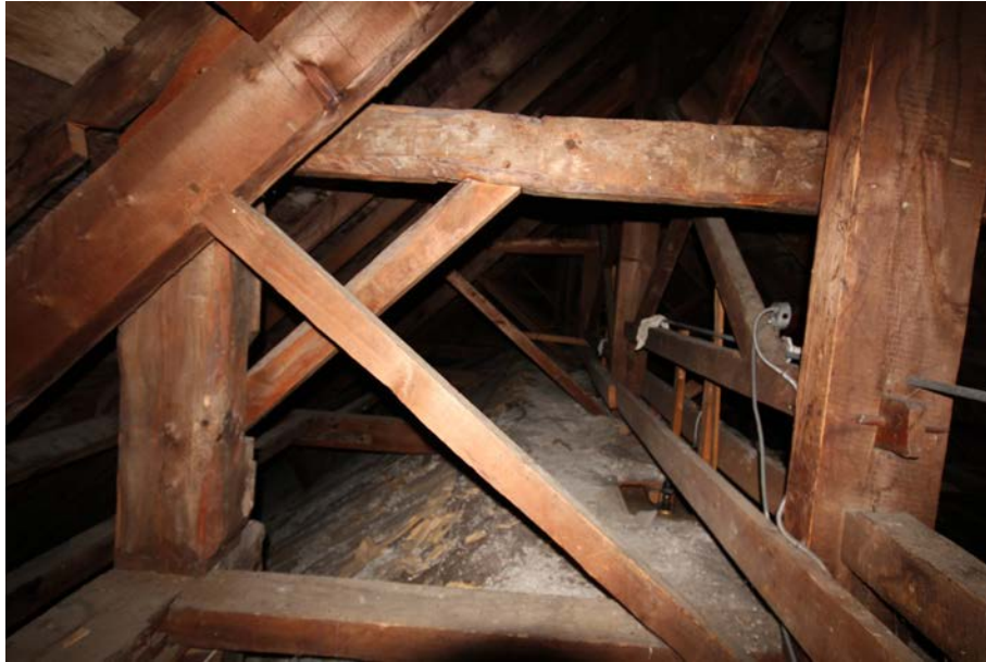
25. La charpente du toit de l'église (photo Sébastien Daviau)
