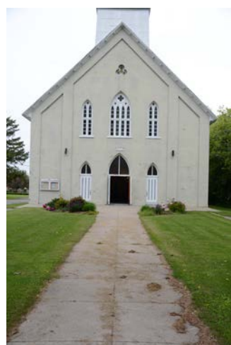
29. La façade de l'église Saint-Étienne (photo Luc Noppen)
