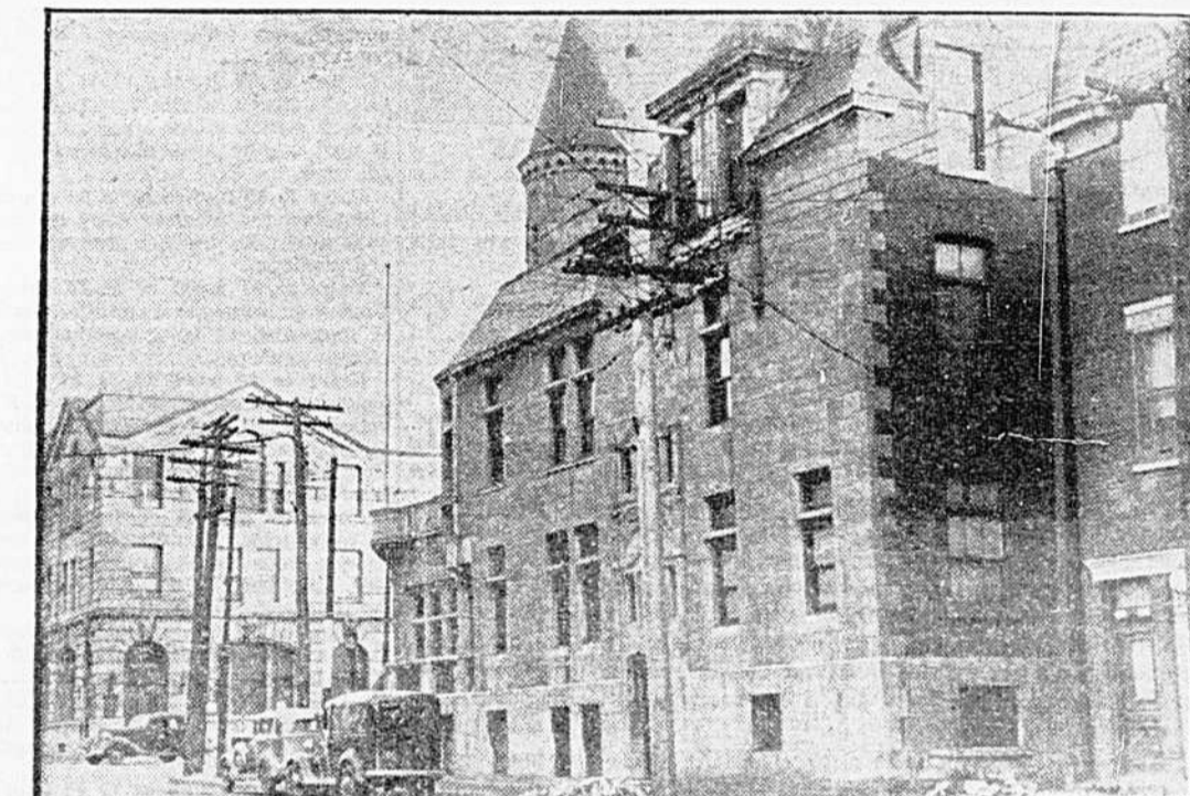
Ce poste de police disparaîtra-t-il?—Il est fortement question de fermer le poste de police situé à l'angle du boulevard St-Laurent et de la rue Laurier (ici photographié). Une requête protestant contre ce projet a été présentée au conseil municipal par un groupe de citoyens de la paroisse de Saint-Enfant-Jésus et l'on espère que le conseil municipal se rendra à cette demande. (Photo "L'Illustration Nouvelle".)
