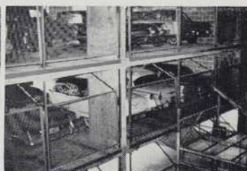
Vue des niveaux supérieurs de stationnement
