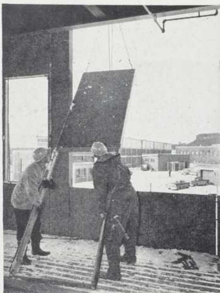
Cette section de mur-écran se pose comme une fenêtre double. Des équipes de 3 hommes réalisent une installation rapide.
