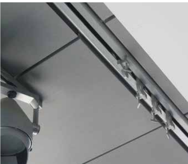
3.1) Ancre continu rigide et permanent
