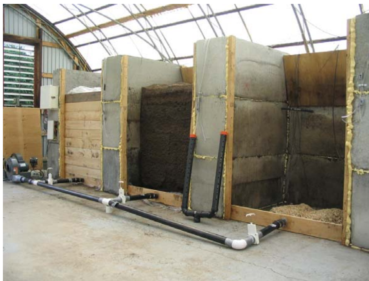
Figure 32: Montage des cellules de conditionnement
