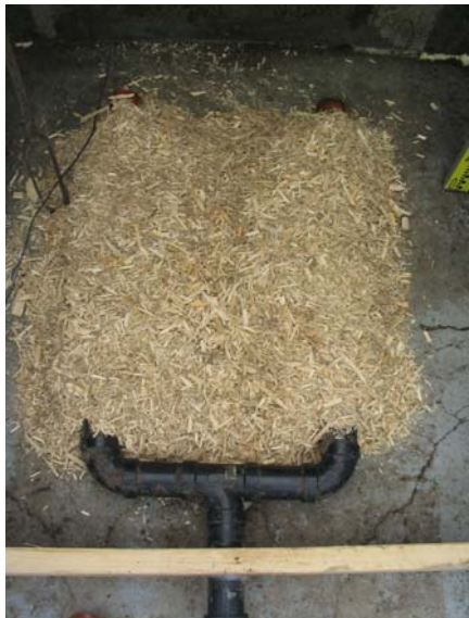
Figure 33: Montage du plénum de ventilation
