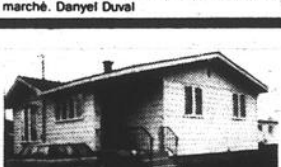
RM 179. BUNGALOW: renové 3 ans, fenêtres porte-patio, 4 chambres, prix: 53 000$. Gilles Frégeau
