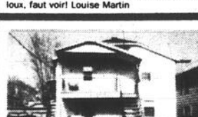
RM 151. IBERVILLE: duplex 2 x 4 1/2, chauffage électrique refait. Danyel Duval
