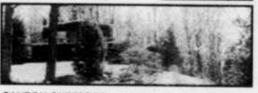
CANTON SHEFFORD : Dos à la montagne, sur plus de 76 000 pi.ca. de terrain boisé, bung. 2 c.c., sous-sol aménagé, grande galerie sur deux côtés de la maison, offrant une vue magnifique sur la vallée et les montagnes. 201-C414599
