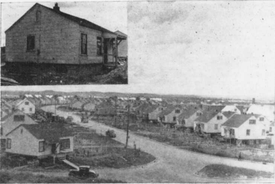
Les travaux de construction de caves en béton à 171 des anciennes maisons du Wartime Housing et maintenant propriété d'Alcan, vont bon train. Les deux contracteurs, la Foundation Company, de Montréal, et la Pic Construction, d'Arvida, ont charge des travaux. La photographie ci-dessus prise, la semaine dernière, sur la 28ième rue, nous donne une bonne idée de l'ampleur des travaux. L'on remarquera à droite, quelques maisons qui ont été reculées et placées sur des pilotis afin de permettre le creusage de la cave. Ce déplacement des maisons est fait sans que les locataires aient à quitter les lieux. Un système d'égoût est installé temporairement à chacune des maisons. Il en est de même des services d'eau et d'électricité. Dans le médaillon, l'on remarquera une maison dont la cave est terminée. Dans chacune de ces caves l'on installe un système de chauffage à air chaud.
