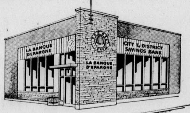
2200 est, rue Fleury, angle Parthenais
