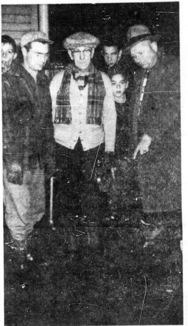
BRIS DANS UN TUYAU D'AQUEDUC — Les employés du service de l'aqueduc de la ville de Hull ont travaillé toute la nuit à la lumière de projecteurs pour réparer un bris qui s'est produit vers 8 heures hier soir dans un tuyau d'aqueduc, à l'angle des rues Berri et Laramée. On voit ici le contre-maître du service de l'aqueduc, M. Liguori Laframboise, au centre, qui examine les dégâts causés par l'eau en compagnie de quelques résidents du voisinage. (Photo Champlain Marcell)
