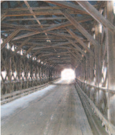
Pont couvert datant de 1931 à Routhierville, Vallée de la Matapédia.
