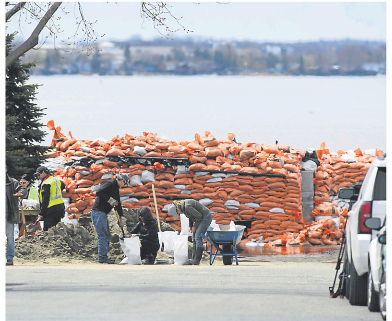
Les inondations printanières de 2017 et 2019 ont mis à rude épreuve la digue de Britannia. — ARCHIVES, LA PRESSE CANADIENNE
