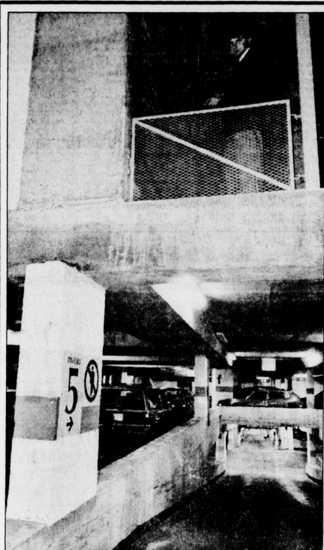
Les jeunes squatters pouvaient assez facilement grimper sur la « mezzanine » qui surplombe le dernier étage du stationnement, comme l'indique le gérant, M. Denis Mercier.
