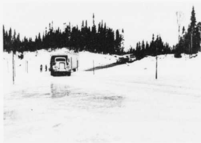
Grâce à la route d'hiver et aux ponts de glace, des véhicules lourds ont pu transporter l'équipement nécessaire à la construction de la route permanente.
