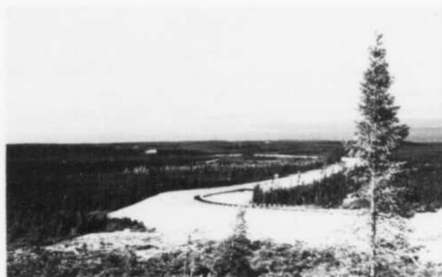
Vue de la route permanente Matagami-Radisson/L.G. 2 aux environs du kilomètre 300.
