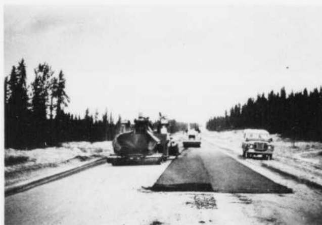
L'usage d'un ciment asphaltique de pénétration 300/400 à faible susceptibilité aux changements de température protège le pavage jusqu'à -50^{\circ}\text{C} .
