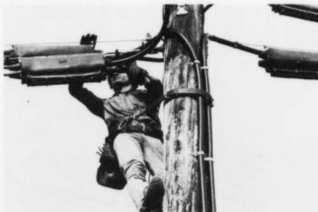
Le réseau compte 250 km de câbles aériens fixés aux poteaux du réseau d'électricité. La plus longue installation de ce genre s'étend sur environ 30 km ; elle alimente l'aéroport de La Grande Rivière, le campement Duncan et le Camp des Pins.
