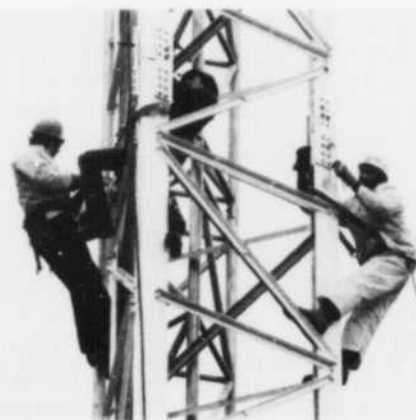
Construction de deux pylônes de 198 m, un à Radisson et l'autre au Lac Julian. Ces pylônes permettront la liaison avec Poste-de-la-Baleine.
