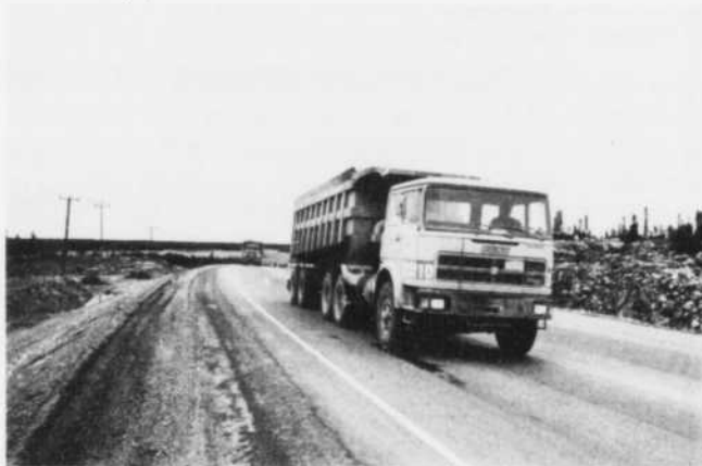
La chaussée est constituée de deux pistes de roulement de 3,6 m de large et d'accotements non pavés de 3 m. L'emprise totale est de 45 m.
