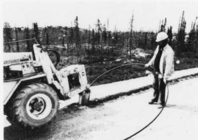
Les câbles furent enfouis sous les épaulements des routes sur une distance d'environ 60 km ; quelque 70 km de câbles furent posés en surface dans les zones peu fréquentées, là où le sol trop rocailleux se prêtait mal à l'enfouissement.
