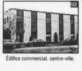
Édifice commercial, centre-ville.
