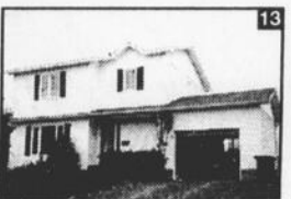
Cottage 3 chambres, garage, Warwick.
