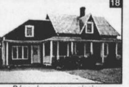
Rénovée, garage, piscine.
