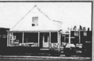
Boul. Bois-Francis nord site commercial, briques, entrée de cave extérieure.
