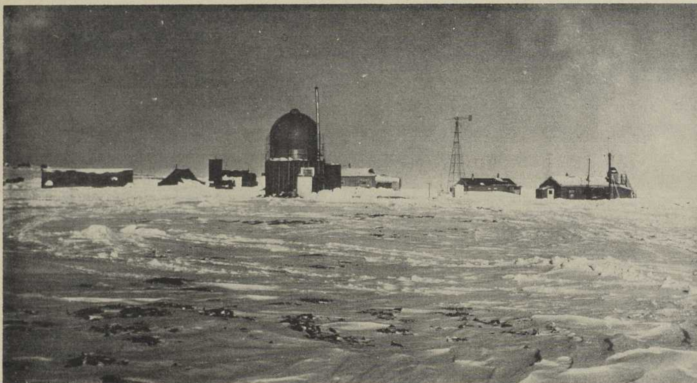
DANS LE CREPUSCULE POLAIRE, LES RAYONS DU SOLEIL ILLUMINENT LA STATION EXPERIMENTALE QUE LE CORPS DES INGENIEURS DE L'ARMEE AMERICAINE A ETABLIE AU GROENLAND. DANS CETTE "CITE SOUS LA GLACE", ON POURSUIT ACTUELLEMENT DES RECHERCHES SUR LES FAÇONS D'UTILISER L'ABONDANTE ENERGIE SOLAIRE POUR RECHAUFFER LES BATIMENTS DE CE LABORATOIRE SIS LE PLUS AU NORD DE NOTRE PLANETE.
