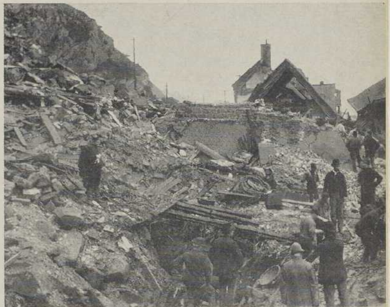
CETTE PHOTO DONNE UNE IDÉE DES DÉGATS QUE CAUSA L'AFFAISSEMENT DE LA PARTIE OUEST DE LA TERRASSE DUFFERIN, A QUEBEC, EN SEPTEMBRE 1889. C'EST SOUS CET AMAS DE DÉBRIS QUE SE TROUVA EMPRISONNÉ UN VIEILLARD DE 74 ANS, M. JOSEPH KEMP.
