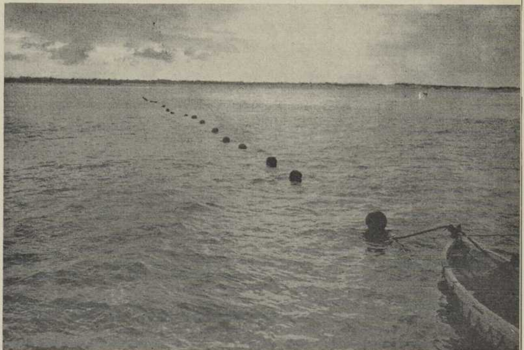
POSE DU CÂBLE TÉLÉPHONIQUE SOUS-MARIN.
