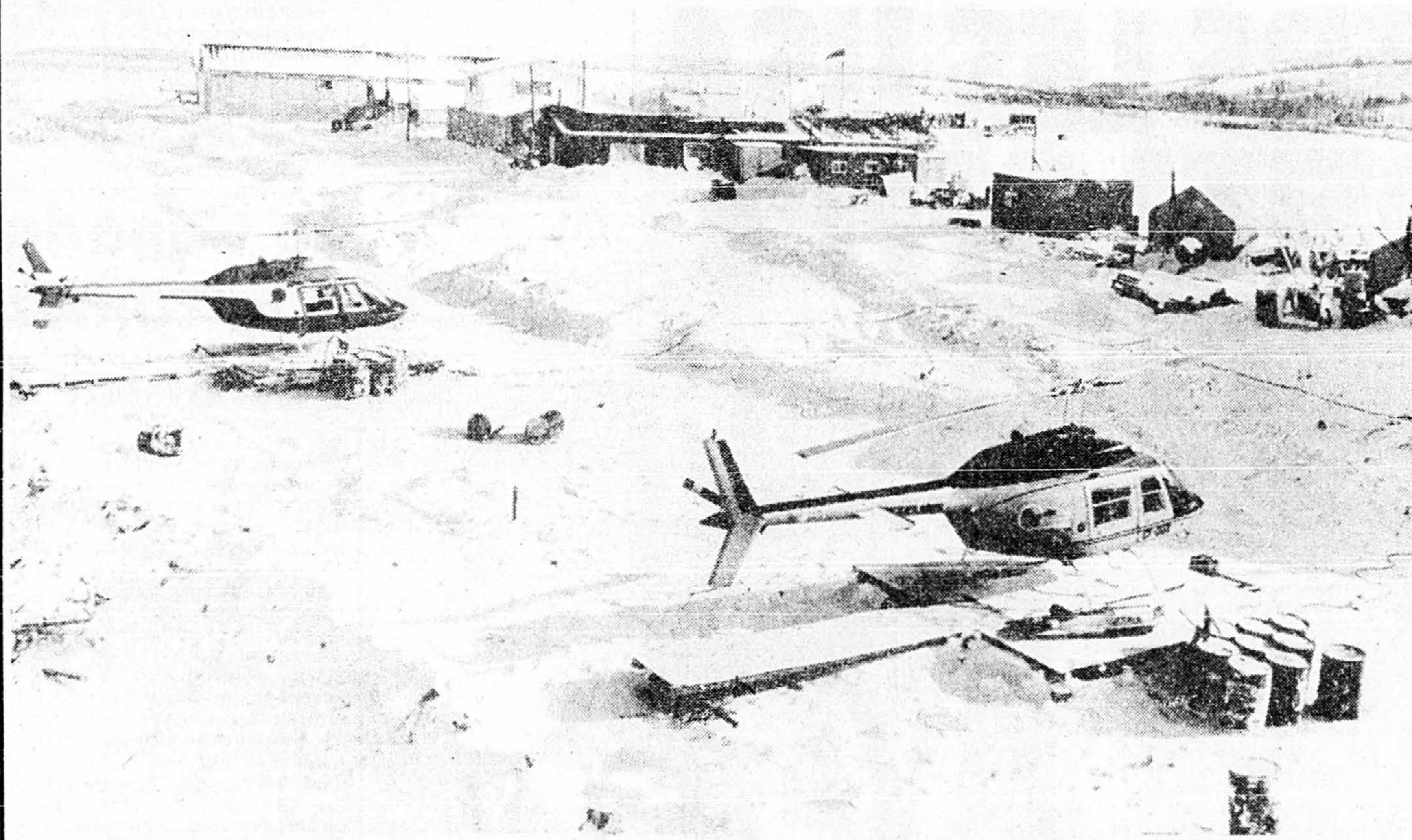
Pour répondre aux besoins des secteurs exploration et environnement de ses travaux d'aménagement hydroélectrique dans le Nord québécois, la Société d'énergie de la baie James a procédé, depuis janvier dernier, au nolissement d'une imposante flottille d'hélicoptères. Ces appareils desserviront le territoire
