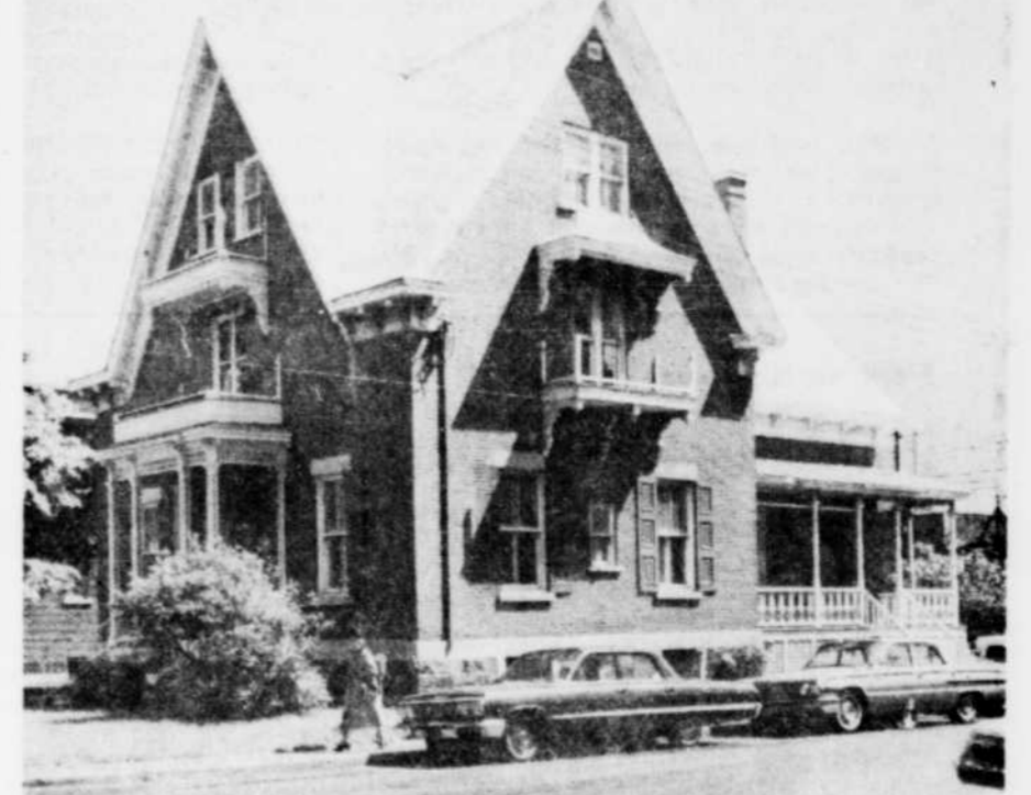
MAISON D'UN STYLE à la fois rare et caractéristique dans la région, la résidence Robichon tombera bientôt sous le pic du démolisseur pour faire place au futur Centre culturel.
