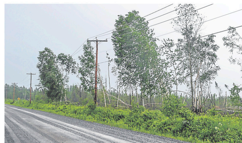
Plusieurs arbres ont été renversés, causant des pannes d'électricité sur le territoire. Les pompiers ont dû intervenir sur le chemin de la Grande Ligne, à Labrecque. — PHOTO LE QUOTIDIEN, GIMMY DESBIENS
