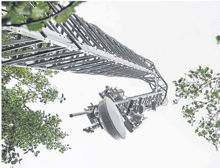
Une tour de télécommunication a été pliée en deux sous la force des vents, dans le chemin des Petits fruits, à Saint-Henri-de-Taillon. — PHOTO LE QUOTIDIEN, GIMMY DESBIENS
