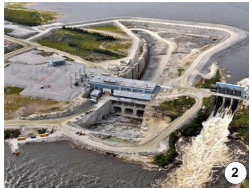
Centrale de la Sarcelle (en construction)
