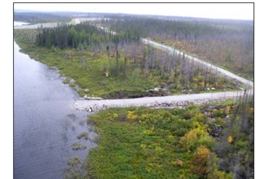
Rampe de mise à l'eau aménagée en rive nord, au PK 110,3 de la rivière Rupert
