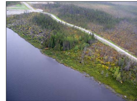
Chemin d'accès au seuil du PK 110,3 et à la rampe de mise à l'eau en rive nord
