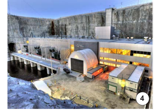
Centrale de l'Eastmain-1-A (en construction)
