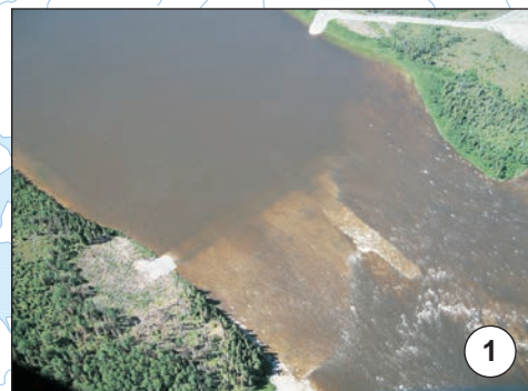
Tapis en enrochement du PK 20,4
