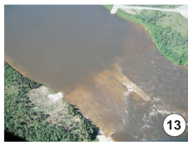
Tapis en enrochement du PK 20,4
