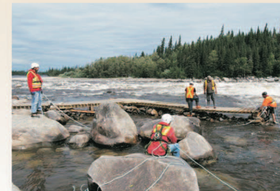
Travaux d'aménagement au site de Smokey Hill
