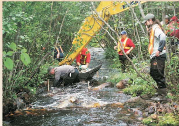
Aménagement d'une frayère à ombre de fontaine
