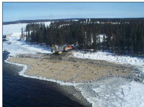
Frayère multispécifique aménagée au pied du seuil du PK 110,3 (en rive sud, sur le terrain de Nemaska)
