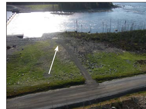
Point de vue au seuil du PK 110,3, rive nord
