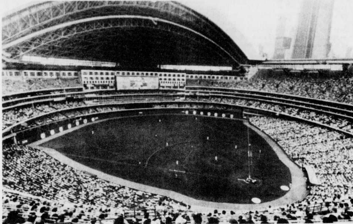
Lorsqu'on a entrepris la construction du SkyDome en 1985, le coût ne devait pas dépasser 60 millions $. Mais le coût total du stade a rapidement grimpé, avec l'ajout d'un hôtel et d'un centre de conditionnement physique. En 1991, son coût se situait à 580 millions $.
