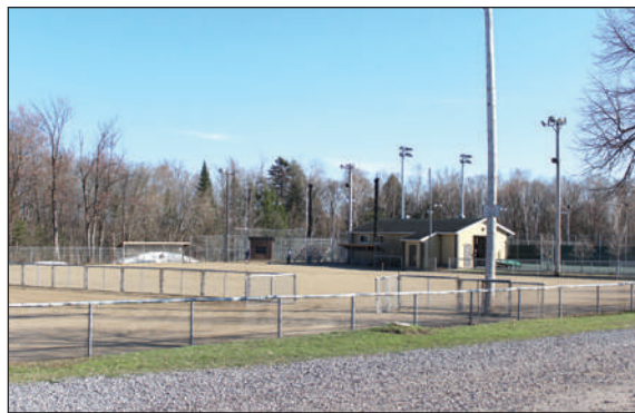
Une vue globale des terrains de baseball 2 et 3. Ils seront complètement refaits à l'automne.
