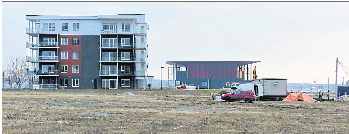
Un nouveau chantier de construction de l'Adresse sur le fleuve pourrait débuter dès février sur le site de Trois-Rivières sur Saint-Laurent. — PHOTO: FRANÇOIS GERVAIS
