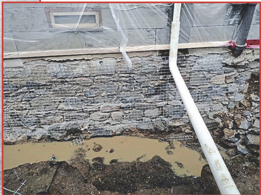
L'étape de l'excavation pour garnir en moellon. La fondation en moellon est constituée de pierres surperposées. Ces pierres sont jointes par du mortier composé en grande partie de chaux. Cette fondation permettait de soutenir la maison ou l'immeuble afin de lui assurer solidité, sûreté et résistance dans le temps. Les méthodes d'aujourd'hui ont bien évolué.
