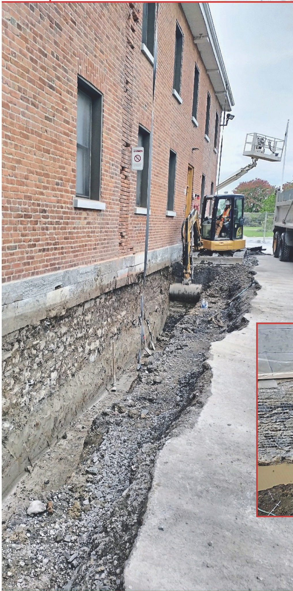
L'étape de l'excavation pour garnir en moellon. La fondation en moellon est constituée de pierres surperposées. Ces pierres sont jointes par du mortier composé en grande partie de chaux. Cette fondation permettait de soutenir la maison ou l'immeuble afin de lui assurer solidité, sûreté et résistance dans le temps. Les méthodes d'aujourd'hui ont bien évolué.
