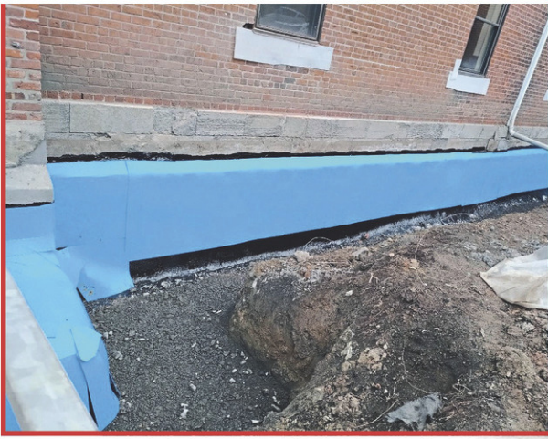
Mise en place d'une membrane de haute performance. Cette membrane est utilisée lors de l'installation de toitures.
