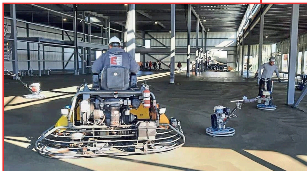
Cette coulée de béton a mobilisé plus de cent travailleurs de différents corps de métiers et a duré plus de 24 h en continu. Projet réalisé par Gaétan et Philip.
