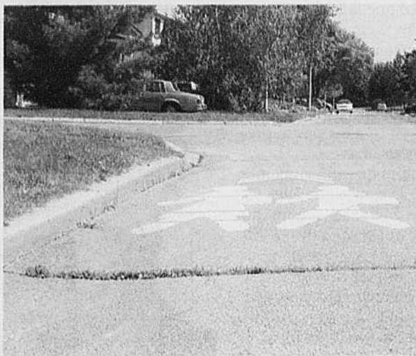
Les bordures de trottoir bleues délimitant les corridors scolaires près de l'école Les Jeunes Découvreurs, à Boucherville, ont été effacées.
