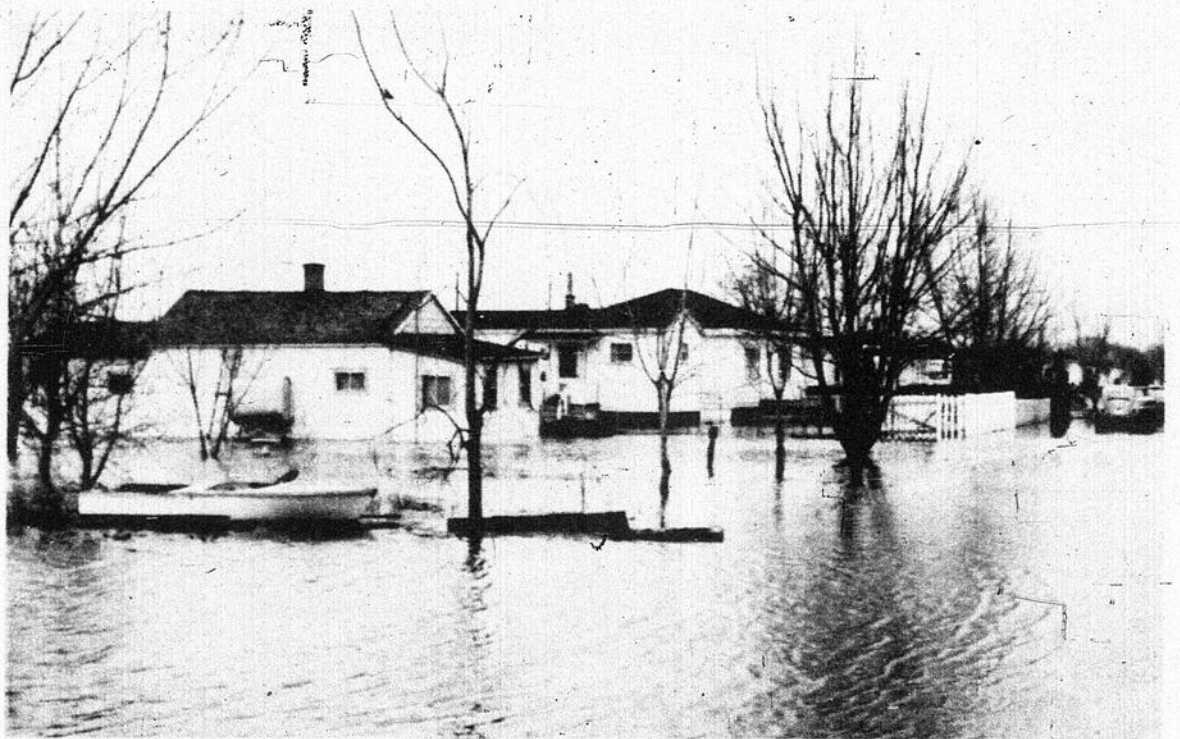
DE L'EAU! DE L'EAU! Le niveau de la rivière Richelieu est monté encore de deux pouces depuis ces derniers jours, causant des dommages assez considérables, comme on peut le constater sur cette photo prise entre St-Jean et St-Paul Ile aux Noix.
