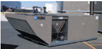
3.2 Système de ventilation/conditionnement de l'air de toiture
