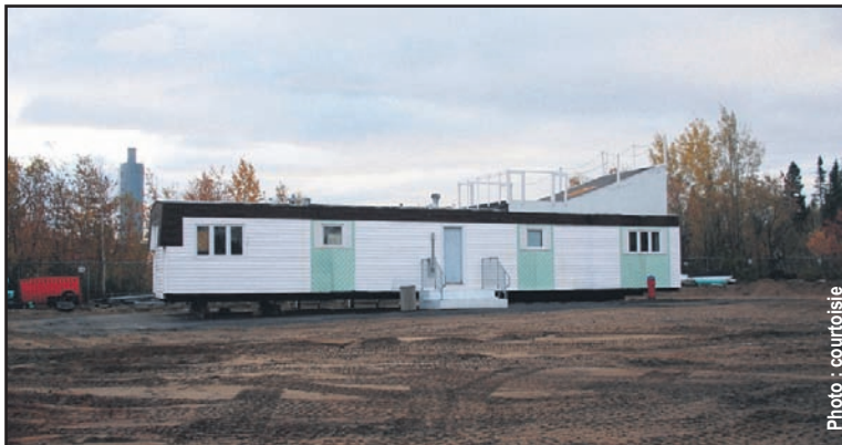
Cette maison mobile est le nouveau Centre d'entraînement du Service incendie de Forestville. Il rencontre tous les critères de l'École nationale des pompiers du Québec en vue de l'accréditation des pompiers et pompières.
