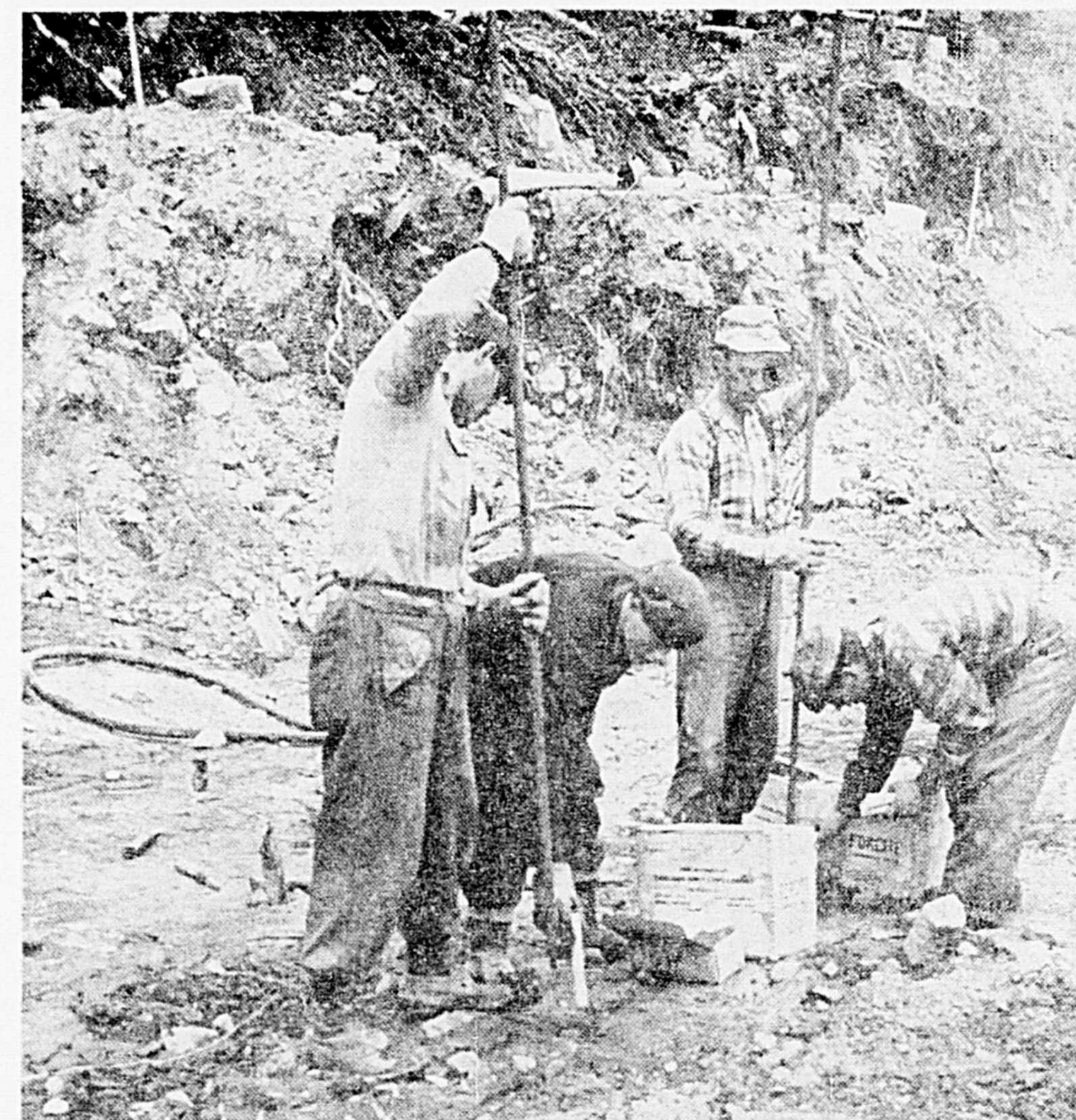
Grâce à la dynamite on parvient à se tailler un passage dans le flanc des montagnes. Dans la vallée de la rivière Cran, à 26 milles au nord-ouest de St-Félicien, plus de 25.000 livres de dynamite seront requises pour une seule explosion.
