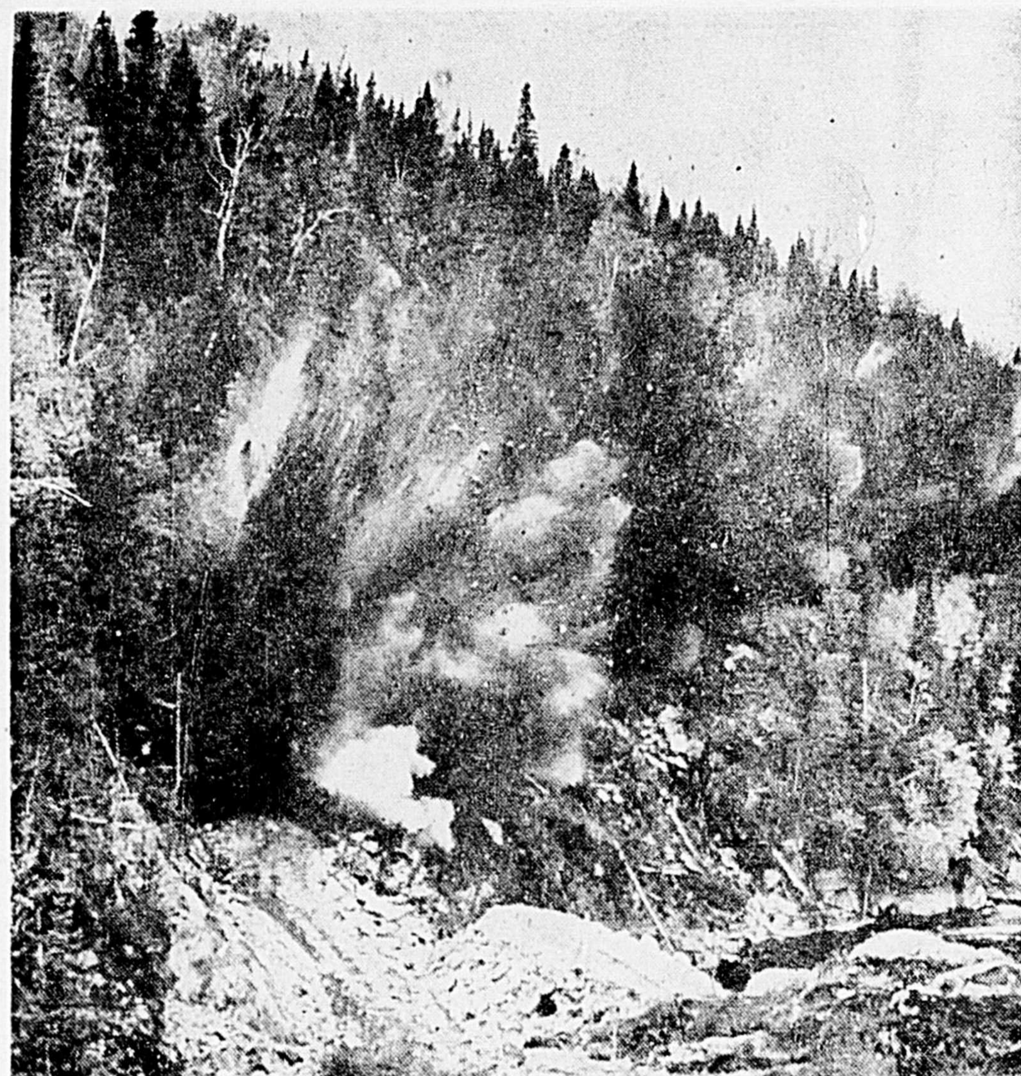
Des centaines de tonnes de roc sont réduites en poussière. Il a fallu plusieurs jours de travail pour aboutir à cette explosion qui ne durera qu'une fraction de seconde.
