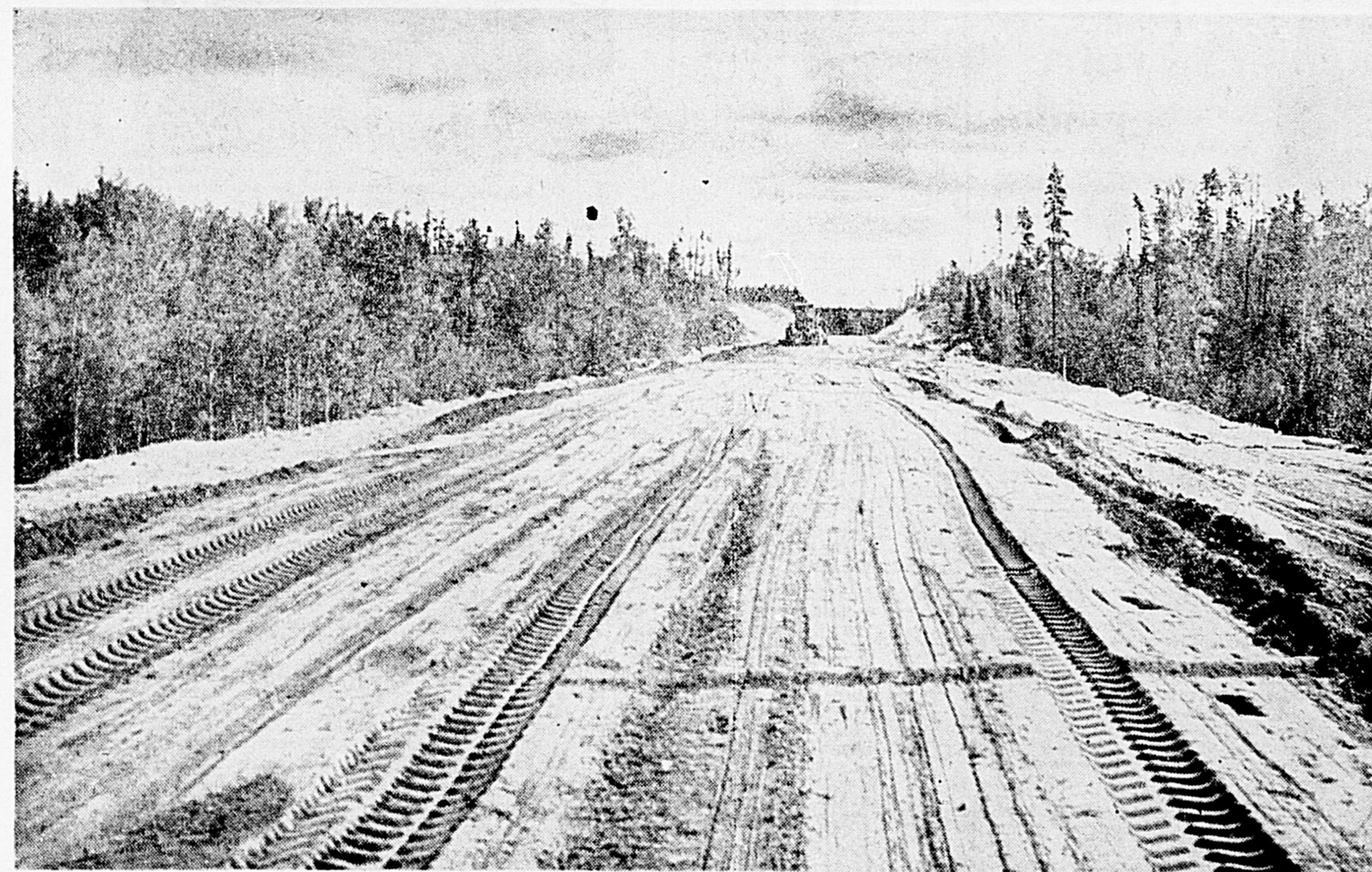
Le terrassement de la voie constitue une étape importante de la construction ferroviaire. Le rail, en effet, doit reposer sur une surface aussi horizontale que possible. Voilà pourquoi, dans des régions aussi accidentées que le nord québécois, la construction ferroviaire est un véritable défi à l'invention de l'homme.
