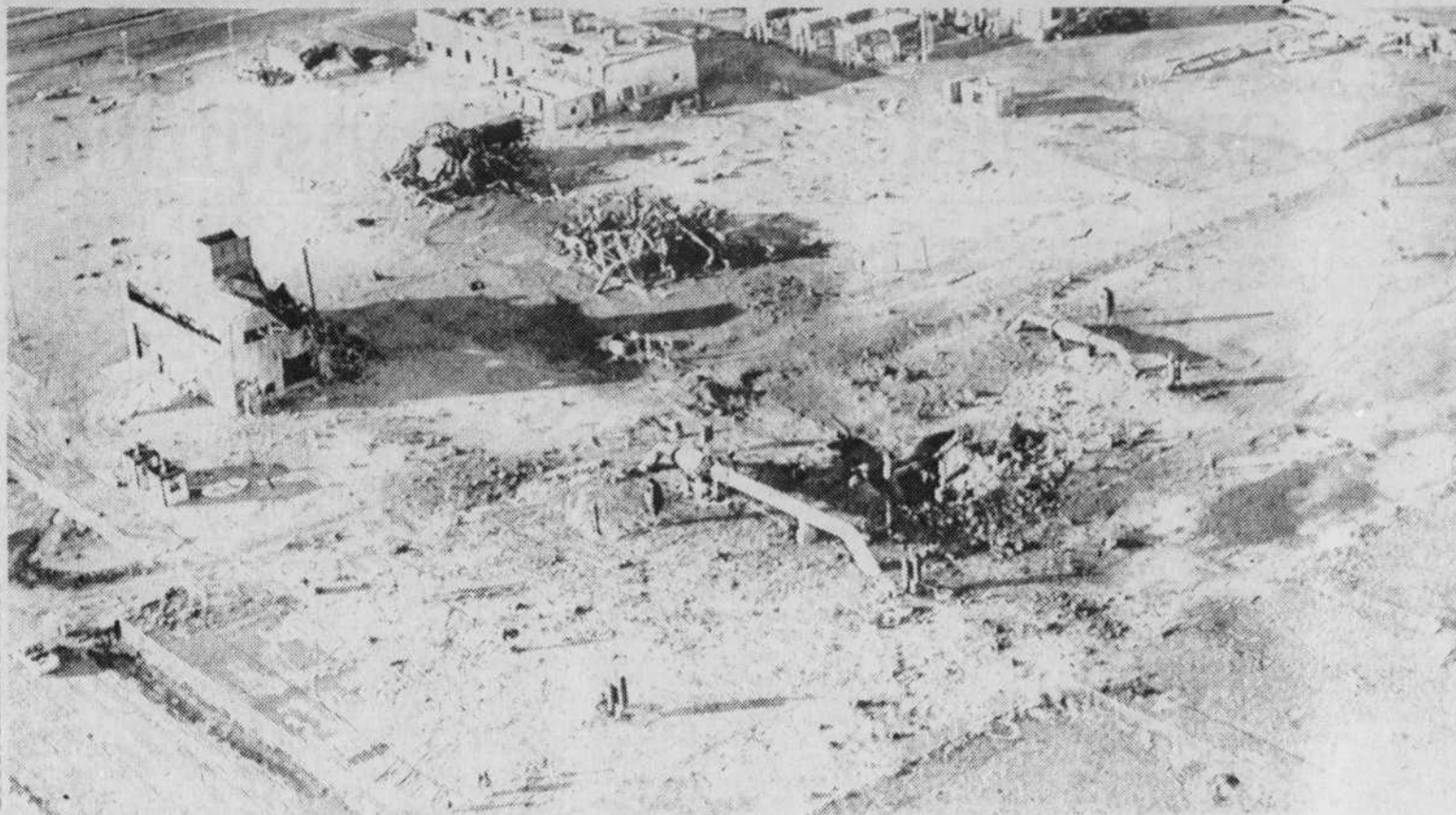
Une explosion de gaz naturel s'est produite mardi soir près de la localité de Brooks, dans le sud-est de l'Alberta, occasionnant des dégâts estimés à plusieurs millions de dollars et entraînant l'évacuation d'une quinzaine de familles. La station de pompage principale de l'Alberta Gaz Trunk Line Co. Ltd a été détruite, réduisant de deux tiers le flot de gaz naturel destiné à l'Est du Canada. Près de trois milliards de pieds cubes de gaz naturel sont normalement acheminés vers l'Est chaque jour, et les autorités estiment que tout sera rentré dans l'ordre aujourd'hui. (Photolaser CP)
