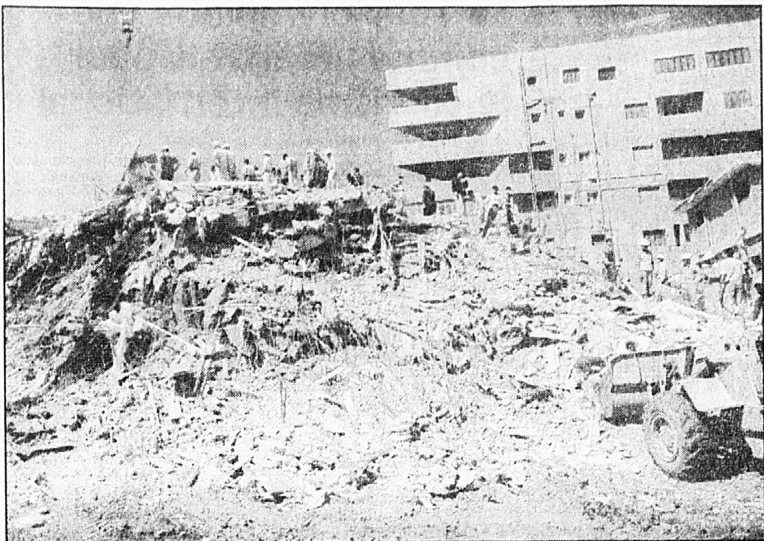
Des ouvriers fouillent les ruines de ce qui était un édifice de 16 étages, à Héliopolis, banlieue du Caire.
