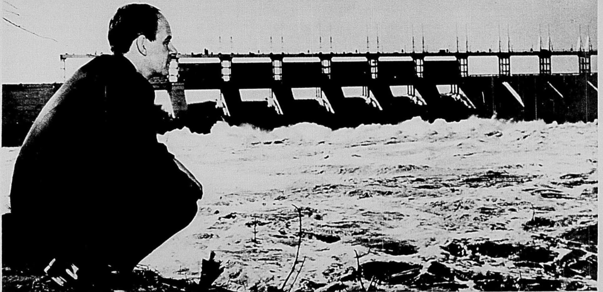
Au barrage de Carillon, sur l'Otaouais. L'Hydro-Québec achève la construction de l'important ouvrage.
