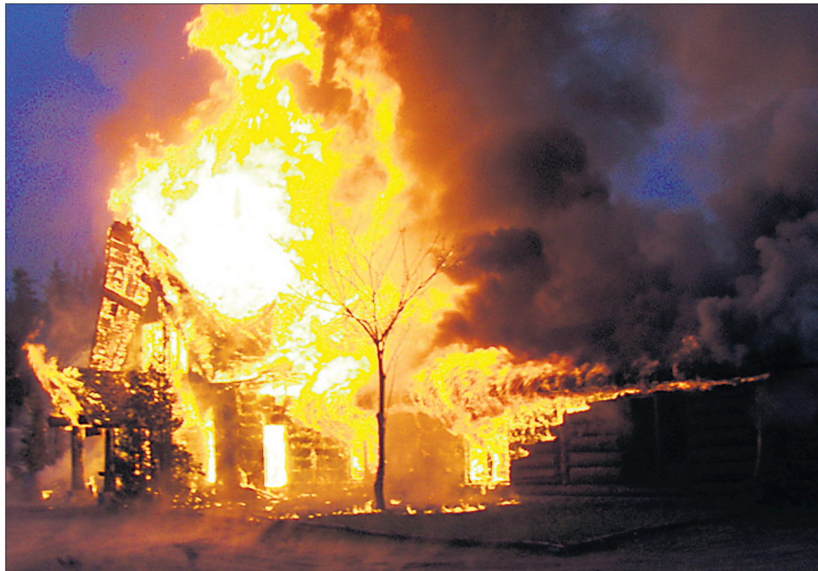
L'incendie s'est propagé très rapidement à l'édifice entièrement construit en bois.
