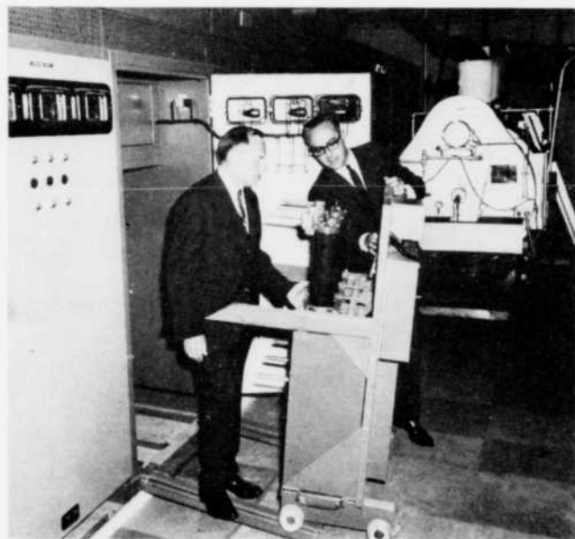
MM. Jean-Paul Boulay, ing. (à gauche) et Jean-Paul Grenier examinent l'un des disjoncteurs de la sous-station électrique de Bois-Fontaine "A". La dernière bouilloire de l'ancienne installation, que l'on aperçoit à l'arrière plan, disparaîtra bientôt et tous les systèmes de l'immeuble fonctionneront à l'électricité.
