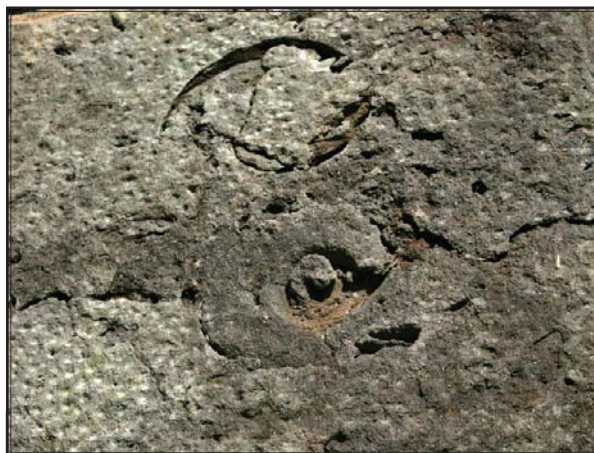
Rez-de-chaussée, rue Mont-Carmel : calcaire de Chazy alvéolé et dolomie brune; gastéropodes Maclurites Magnus Lesueur d'âge ordovicien.
