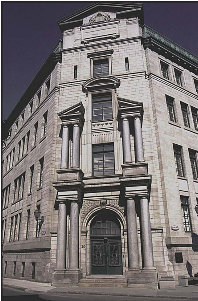
Ancien pavillon des Sciences commerciales revêtu de calcaire de Saint-Marc-des-Carières et ornementé de colonnes en granite Gris Stanstead.
