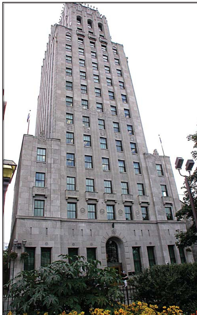
Édifice Price revêtu en partie de calcaire de Saint-Marc-des-Carrières, en partie de calcaire de Queenston. Des panneaux de Queenston ont été remplacés par du calcaire d'Indiana en 2012.
