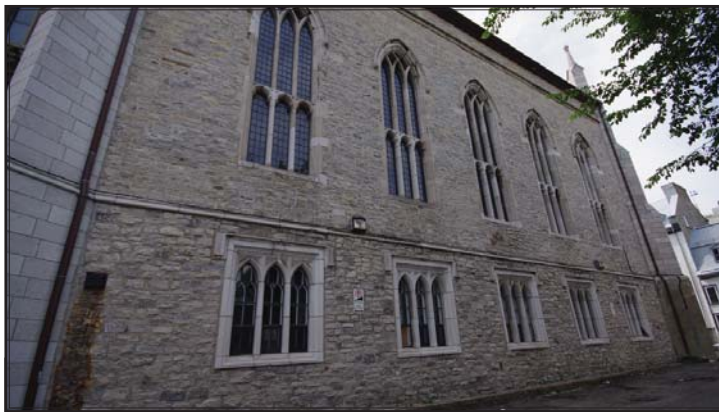
Mur latéral du côté nord en moellons de calcaire de Beauport; l'encadrement des fenêtres carrées est en calcaire de Saint-Marc-des-Carrières.
