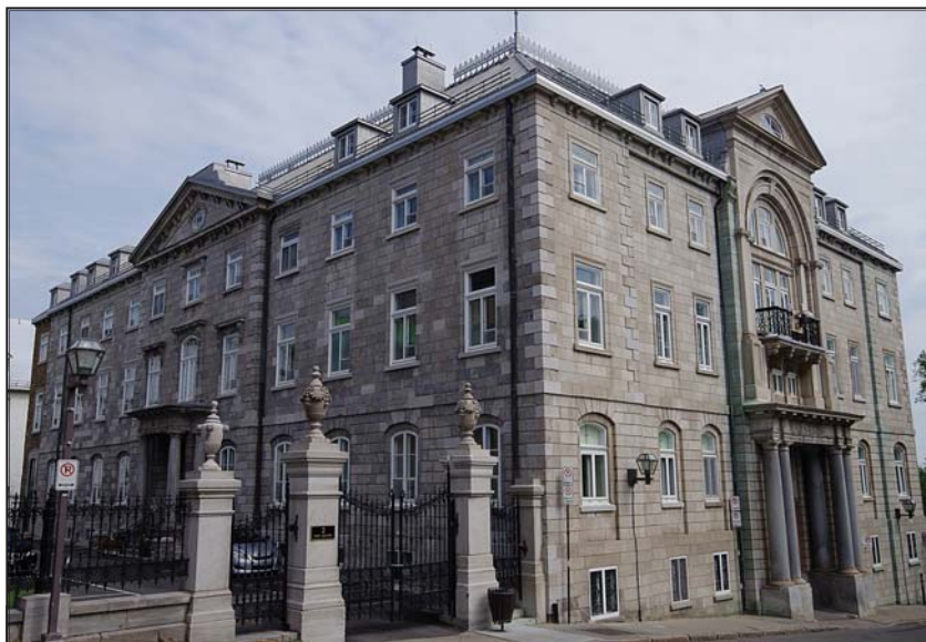
Palais archiepiscopal : la façade et le portail de la rue du Parloir sont en calcaire de Pointe-aux-Trembles; la façade en trompe-l'œil, les piliers et les urnes sur la rue Port-Dauphin sont en calcaire de Saint-Marc-des-Carières; et les colonnes du portail sont en granits Gris Stanstead et Rouge de St-George.
