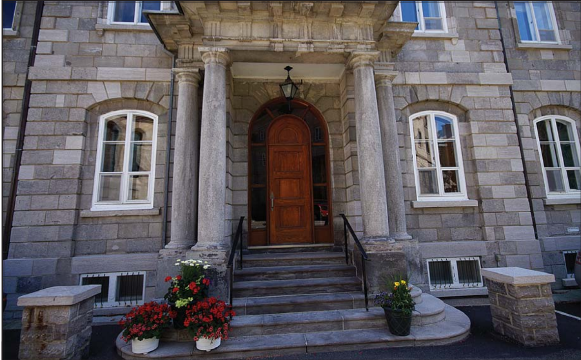
Palais archiépiscopal : portail de la rue du Parloir avec entablement et colonnes doriques en calcaire de Pointe-aux-Trembles. Les pierres architecturales (gris foncé) des murs sont en calcaire de Pointe-aux-Trembles, les pierres de remplacement (gris pâle) sont en calcaire de Saint-Marc-des-Carières.
