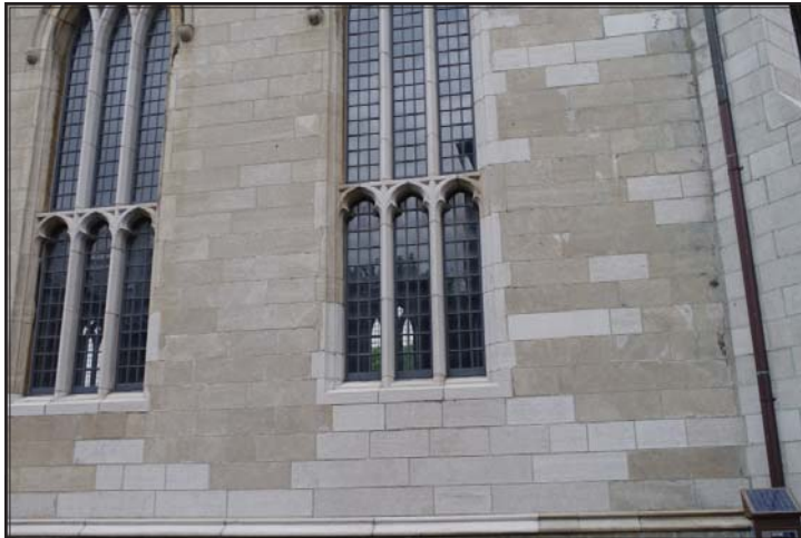
Mur de la rue Dauphine : pierres de taille à patine jaunâtre en calcaire de Montréal; pierres de restauration blanchâtres en calcaire de Saint-Marc-des-Carrières.
