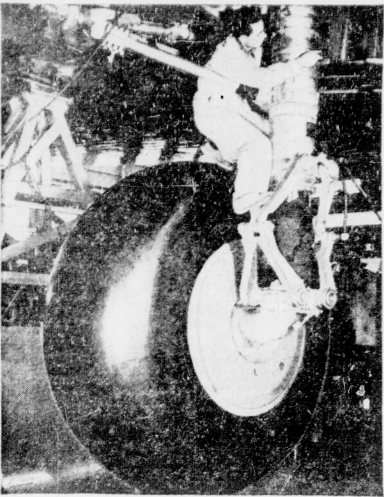
Le bombardier amphibie B-19 est presque terminé par l'installation de cette roue géante d'atterrissage. L'appareil, bientôt, sortira de l'usine de la Douglas Aircraft pour la vérification des instruments et les essais préliminaires, avant de passer au corps aérien de l'armée des Etats-Unis. L'embrayage en tricycle, seul, pesera 9 800 livres, plus que la pesonerie d'un petit bombardier de reconnaissance. Le B-19 sera le plus gros bombardier du monde.
