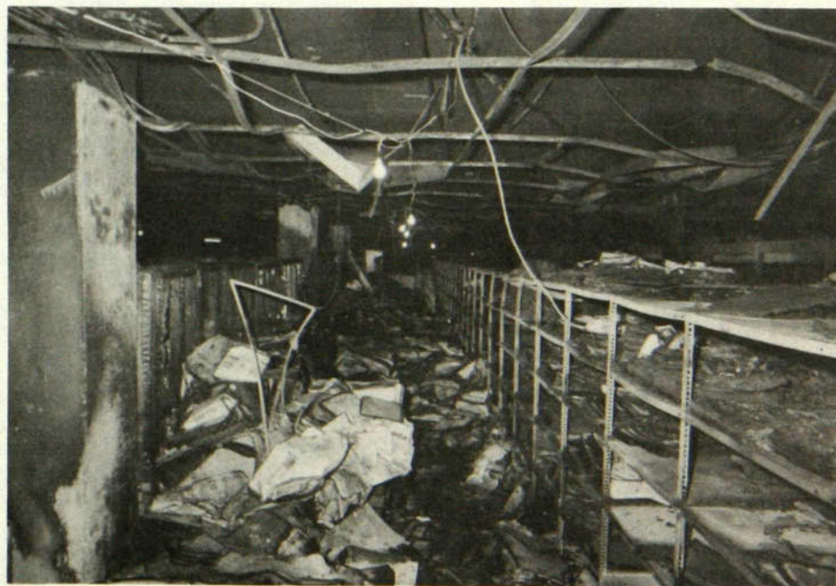
Aspect désolant de la Bibliothèque après l'incendie.
