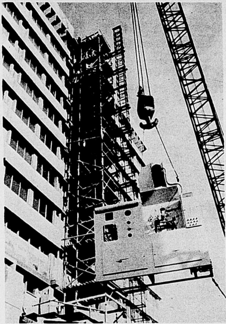
La compagnie Volcano de Saint-Hyacinthe procédait à l'installation de 3 bouilloires la semaine dernière au nouvel hôpital Honoré-Mercier. Les trois unités de chauffage sont constituées de 3 chaudières aquatubulaires, de deux chaudières, d'une capacité de 20 000 livres de vapeur à l'heure. D'une chaudière d'une capacité de 30 000 livres de vapeur à l'heure. Le poids total de ces trois unités de chauffage s'élève à 162 000 livres, et une grue mécanique, comme on le constate sur la photo, les a élevées au 13e étage du nouvel édifice. La consommation totale maximum se chiffre à 580 gallons d'huile par heure. La température de la vapeur sera de 350 F. lorsque ces bouilloires fonctionneront à pleine capacité.
