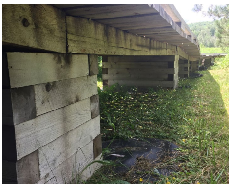
Appui sur assise en caisson ou radier
