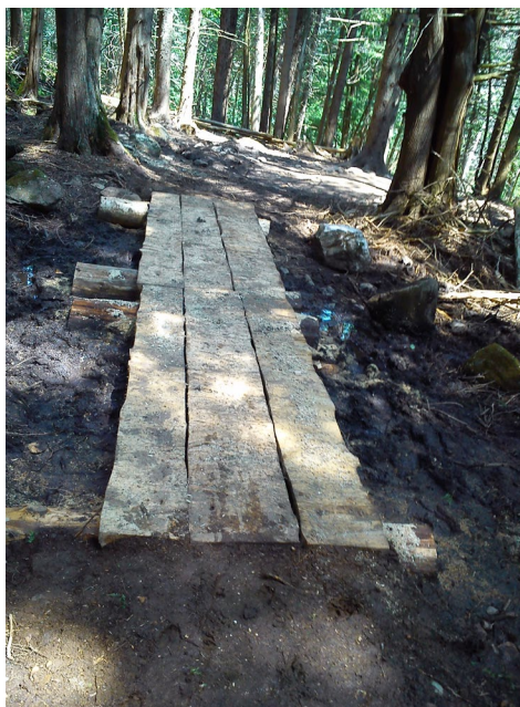
Trottoir de bois sur troncs délinés (split beam)
