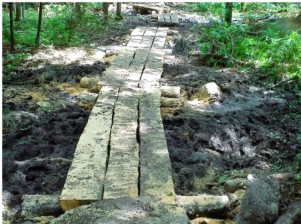
Trottoir de bois sur troncs délinés (split beam)
