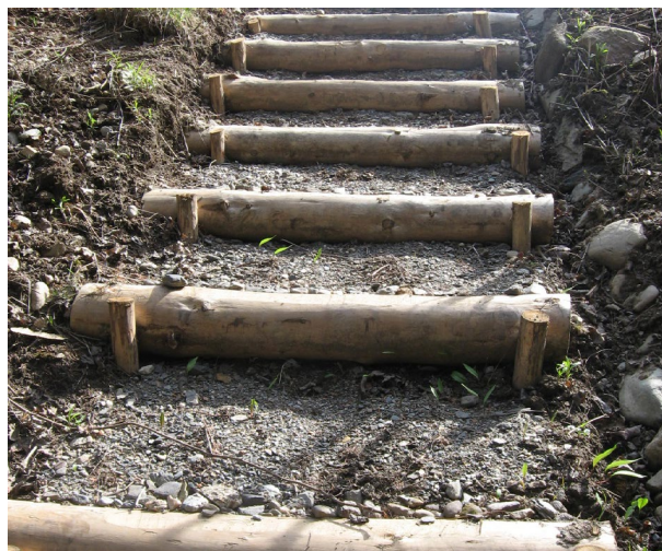
L'utilisation de piquets pour fixer les contremarches n'est pas nécessaire
