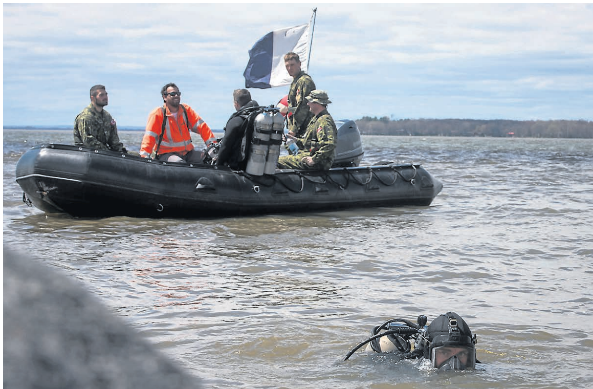
Les plongeurs des Forces armées canadiennes ont été mis à contribution à Nicolet pour inspecter l'état des murets.
