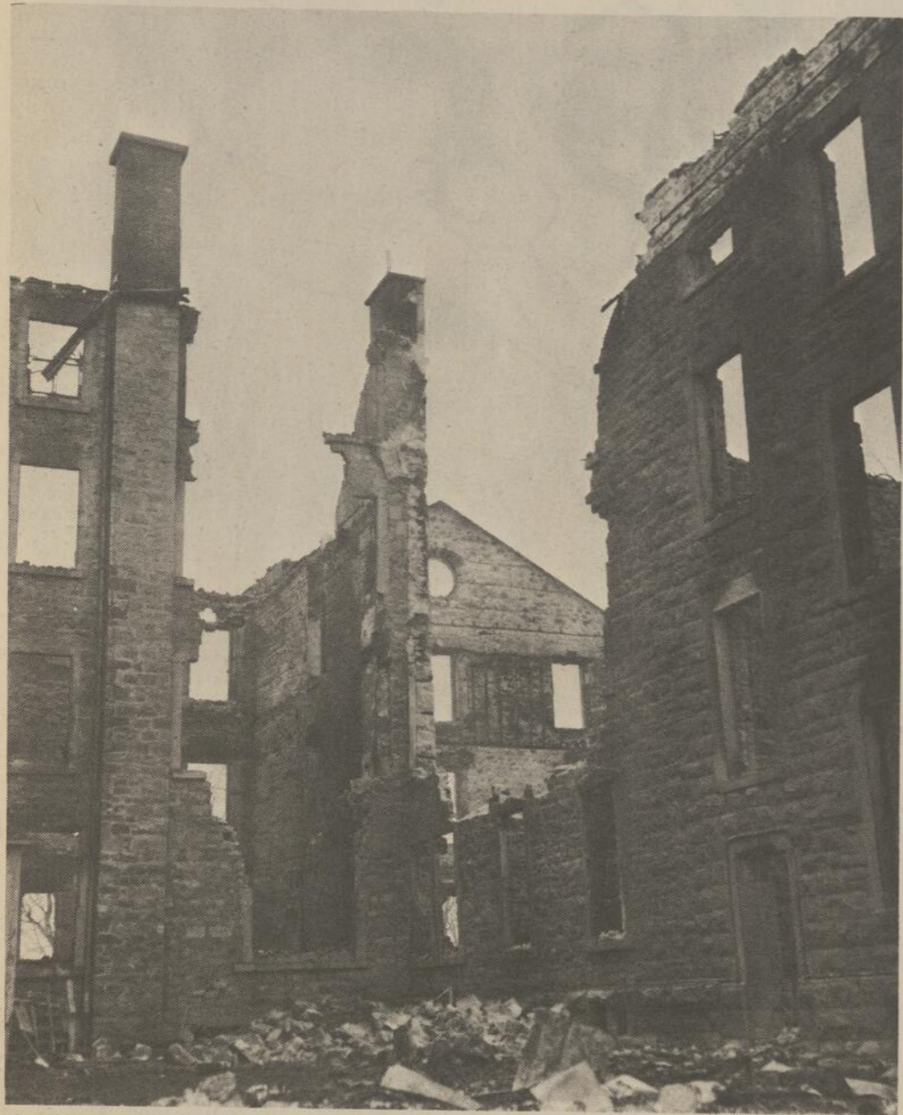
Un désastreux incendie a anéanti les efforts de plusieurs mois de membres de la Corporation de la Résidence Therrien, ancien Institut Feller, où on gardait des adultes retardés, depuis quelques mois. L'incendie a ravagé l'édifice principal qui date de 1848, à la suite d'une explosion survenue dimanche après-midi. Il a fallu onze heures aux sapeurs de Saint-Jean, Iberville et St-Paul Iles aux Noix pour maîtriser les flammes qui ont causé des pertes matérielles évaluées à plus de $500,000.
