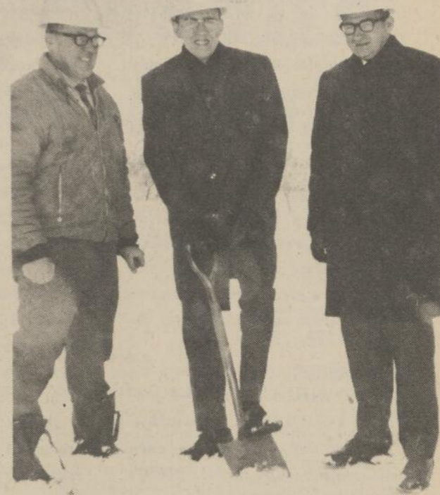
LES TRAVAUX de construction de la nouvelle usine de la compagnie Machineries Harka Inc. débutent. La première pelletée de terre a été levée par M. Paul Leduc, gérant de l'une des succursales locales de la Banque Canadienne Nationale. Celui-ci est entouré de M. Michel Harbec, à gauche, président de la compagnie Machineries Harka Inc., et de M. Denis Dumas, à droite, du bureau d'ingénieurs-conseils Gerald-R. Scott et Associés, lequel a préparé les plans de l'édifice.
