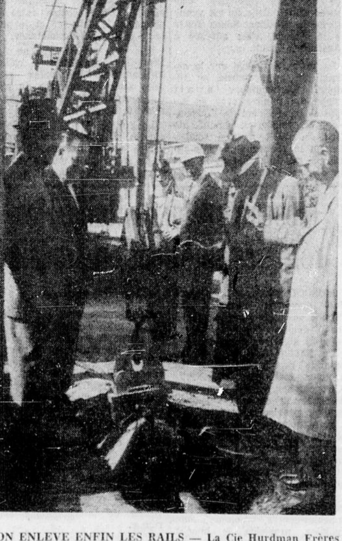
ON ENLEVE ENFIN LES RAILS — La Cie Hurdman Frères a commencé dès lundi matin à enlever les rails de la rue St-Patrice. Une cérémonie marquant l'ouverture du programme des travaux d'hiver à Ottawa s'est déroulée à l'angle des rues St-Patrice et Nelson. On peut voir dans la photo, de gauche à droite, M. Fraser Hurdman, représentant de la compagnie qui fait le travail; le commissaire Paul Tardif; le commissaire Wilbert Hamilton, responsable des travaux de la ville et le maire George Nelms.
