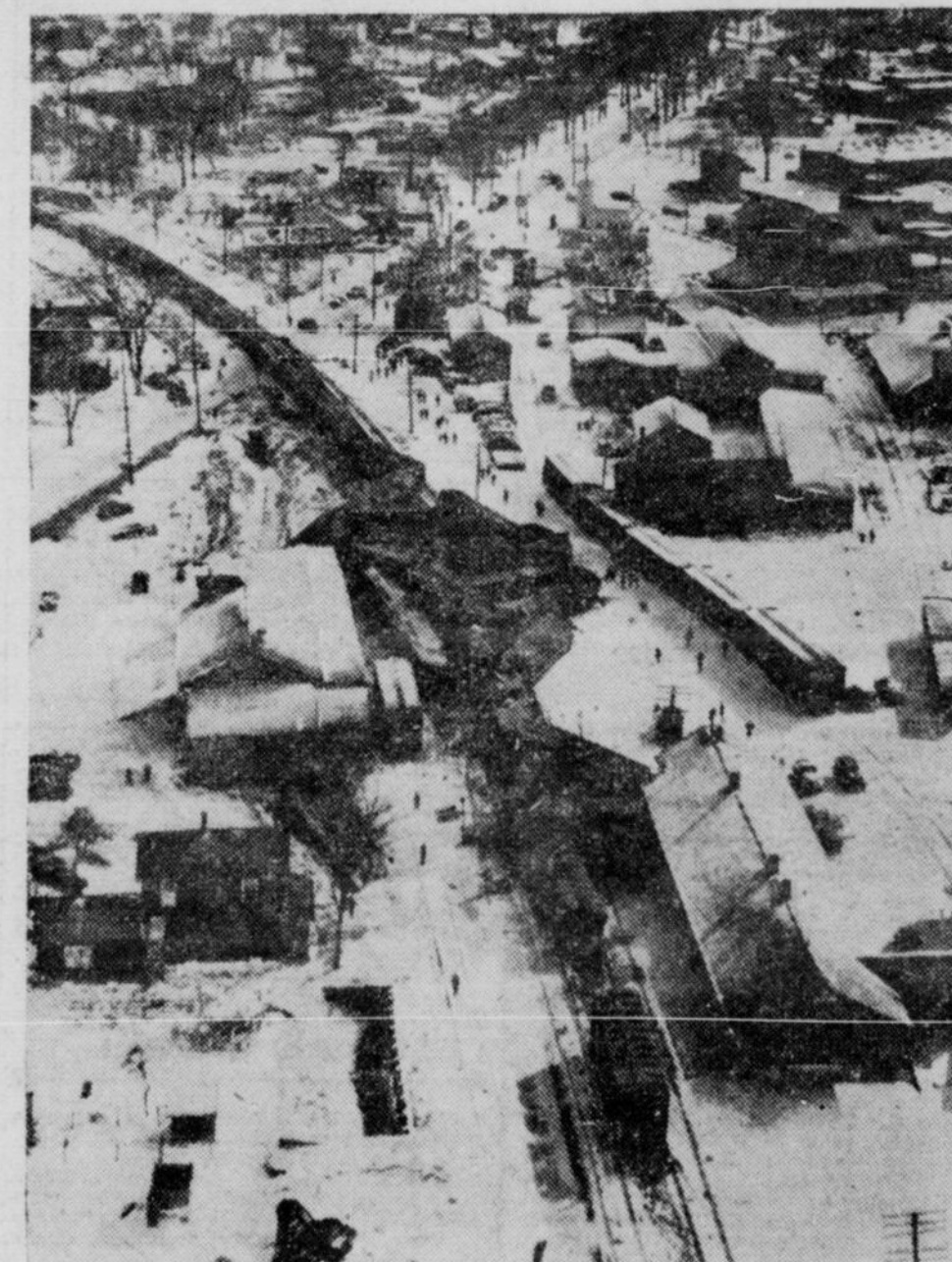
Déraillement causé par un camion
