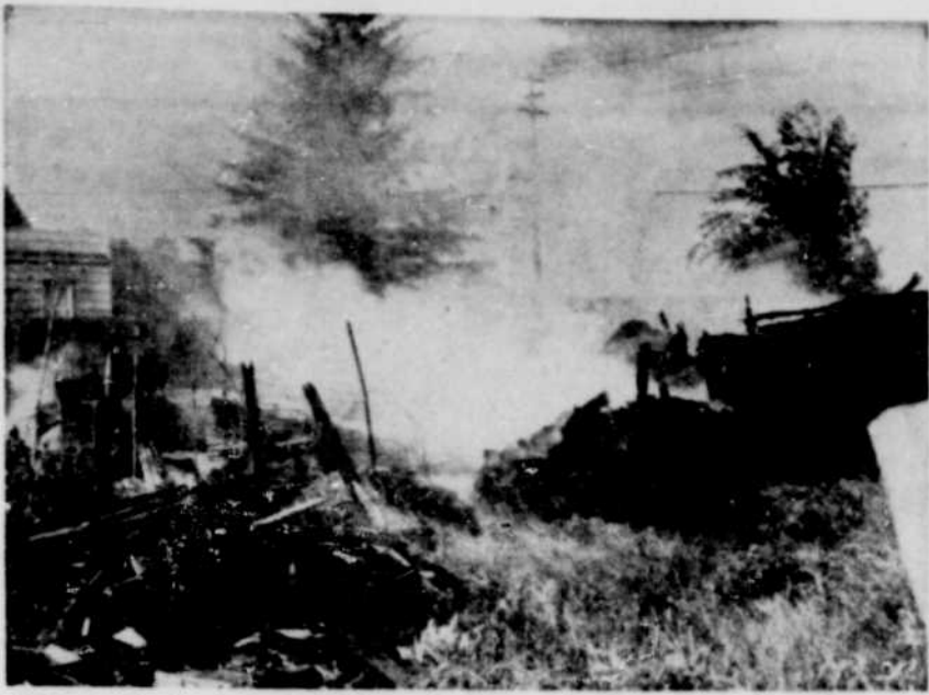
Rasée au sol.— La maison de M. Fernand Turcotte, demeure située à Ascot Corner, a été détruite de fond en comble par un incendie qui s'est déclaré vers 3 heures p.m. hier. Cette photo montre la résidence qui ne révèle que des débris calcinés.
