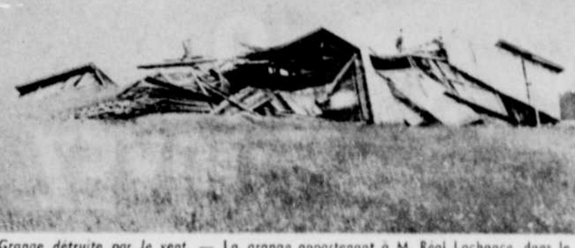
Grange détruite par le vent. - La grange appartenant à M. Réal Lachance, dans le 7e rang d'East Broughton, a été fauchée au sol par le vent violent qui a sévi dans la région de la Beauce mardi.
