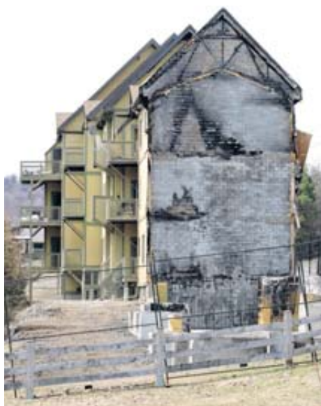
Une partie des condos de la rue des Pins a brûlé en 2016.
