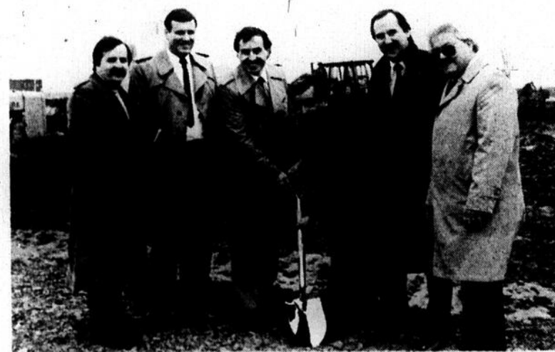
M. Yvon Guillotte procède à la levée officielle de la première pelletée de terre en compagnie du maire Delbert Deschambault. Ils sont entourés de l'architecte Guy Giroux, de M. Gilbert Pépin, de la firme Brault et Bisailon, du commissaire industriel, M. Clément Couture, et du président du Conseil économique, M. Claude Bernier. (Photo François Melillo)
