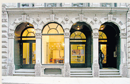
La Cité du nouveau monde occupe des bâtiments historiques du Vieux-Montréal.
