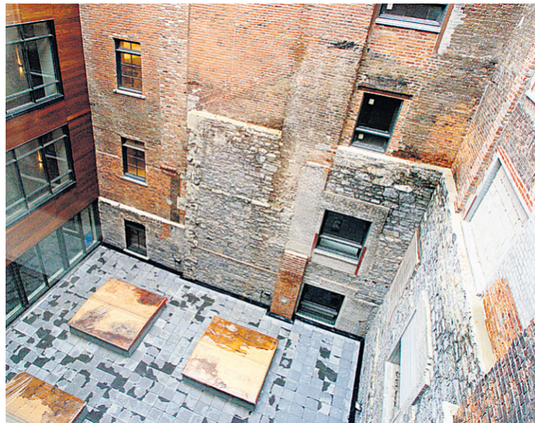
Le promoteur a démolé un bâtiment pour créer une cour intérieure, qui sera bientôt accessible aux résidents.
